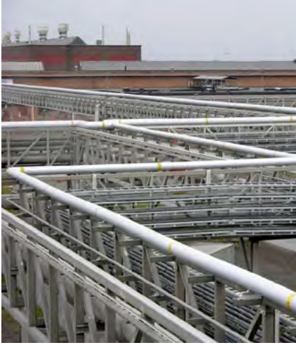
Wibe KHZV tikashylyy asennettuna Outokumpu Terästehdas, Avesta Ruotsi.
