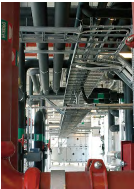
Wibe KHZP tikashylyy asennettuna Kista Tiedekeskus, Ruotsi.
