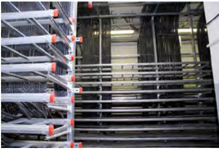
Wibe KHZP tikashylyy asennettuna ydinvoimalaitokseen Venäjällä.
