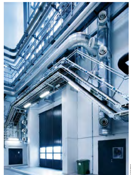
Wibe KHZV tikashylyy asennettuna Gärdstaverken, Ruotsi.
